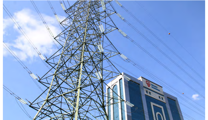
► Menara penghantaran bekalan elektrik Tenaga Nasional Berhad
